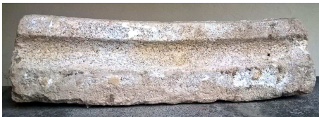
Očištěné žebro gotického ostění z bývalého kostela sv. Alžběty v Jindřichově Hradci.
