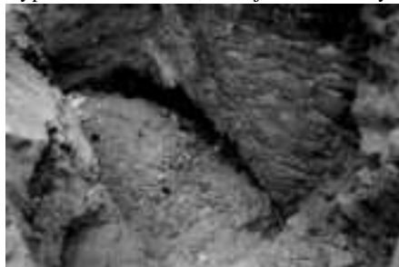
Odkrytá část jednoho z klenebních oblouků mostu přes parkánový příkop
